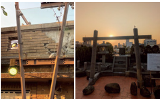
穴の空いた外壁
